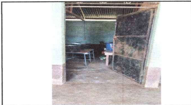
Foto 3: cambiar tres puertas.
